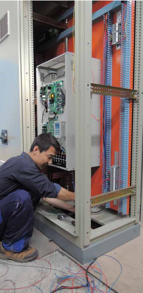
Eric Hou durante el montaje de un armario eléctrico
