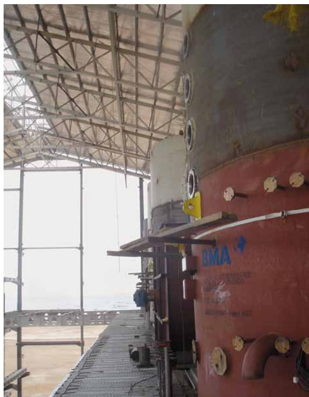
Construcción del cuarto de azúcar de PT. Andalan Furnindo
