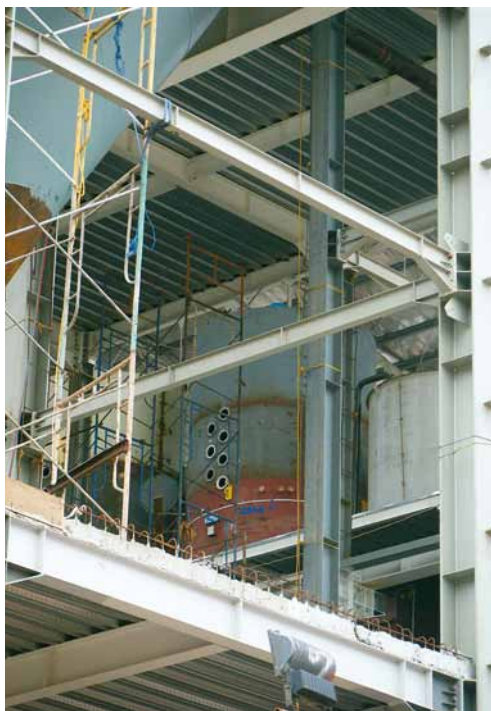
Монтаж испарительных вакуум-аппаратов периодического действия
