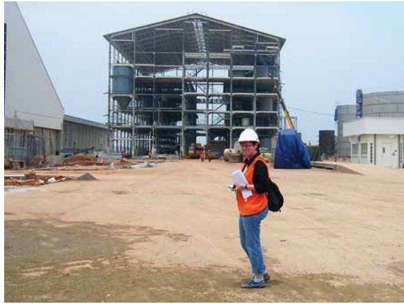
... auf der Baustelle
