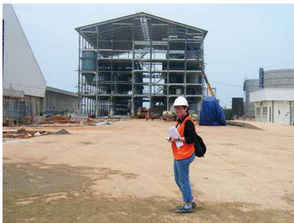
.... sur le chantier
