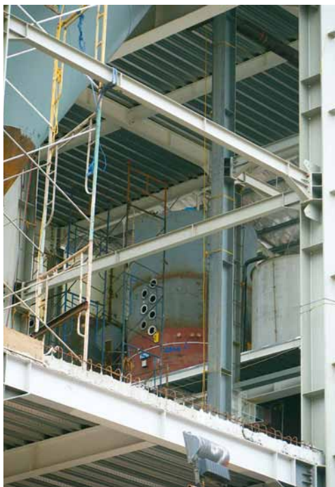
Montage des appareils à cuire discontinus
