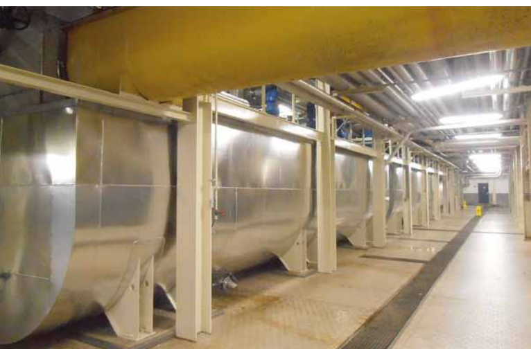
Nouveau refondoir de sucre dans la sucrerie de Dinteloord.
