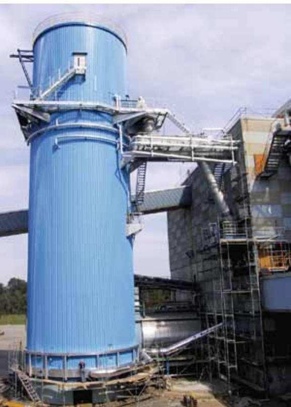
Torre de difusión durante el montaje
