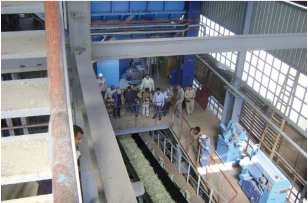
Transporte de las primeras cosetas de remolacha a la instalación de difusión
