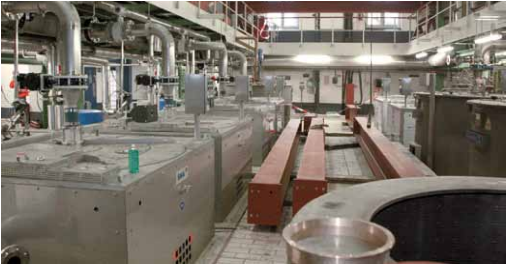
Estación de centrifugas durante los trabajos de montaje
