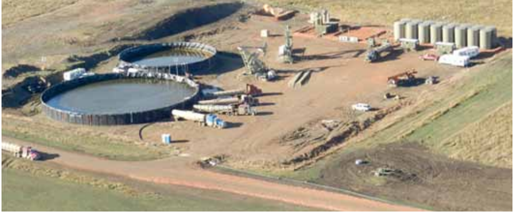
Резервуары для воды на буровой площадке
