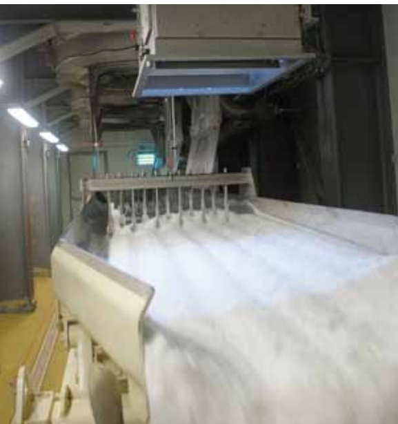
Монтаж колориметра над вибрлотком
