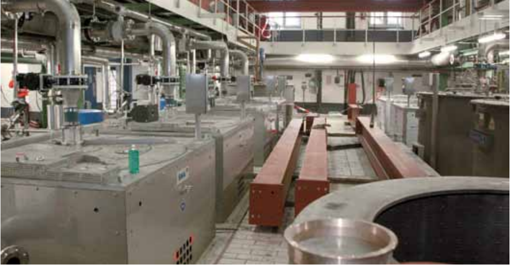
Zentrifugenstation während der Montagearbeiten
