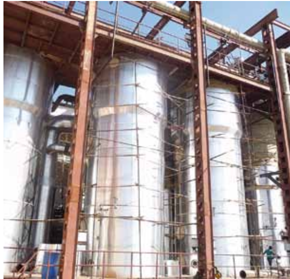
Verdampfanlage während der Rohrleitungsmontage
