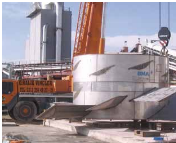
Anlieferung auf der Baustelle in Aksaray
