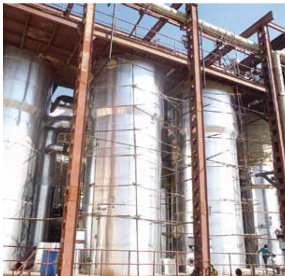
Installation d'évaporation pendant le montage des conduites
