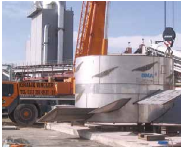
Livraison au chantier à Aksaray
