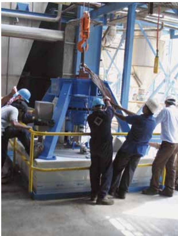
Montaje de las nuevas centrífugas
