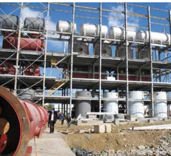
Obra bruta del edificio de la refinería
