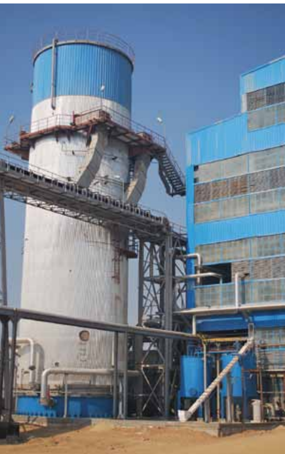
Колонный диффузионный аппарат Ø 9,6 x 22,73 м
