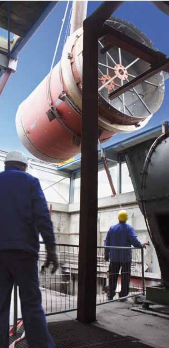
Einheben der Trommel- segmente
