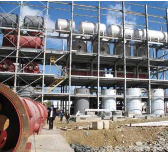
Rohbau Raffinerie- gebäude
