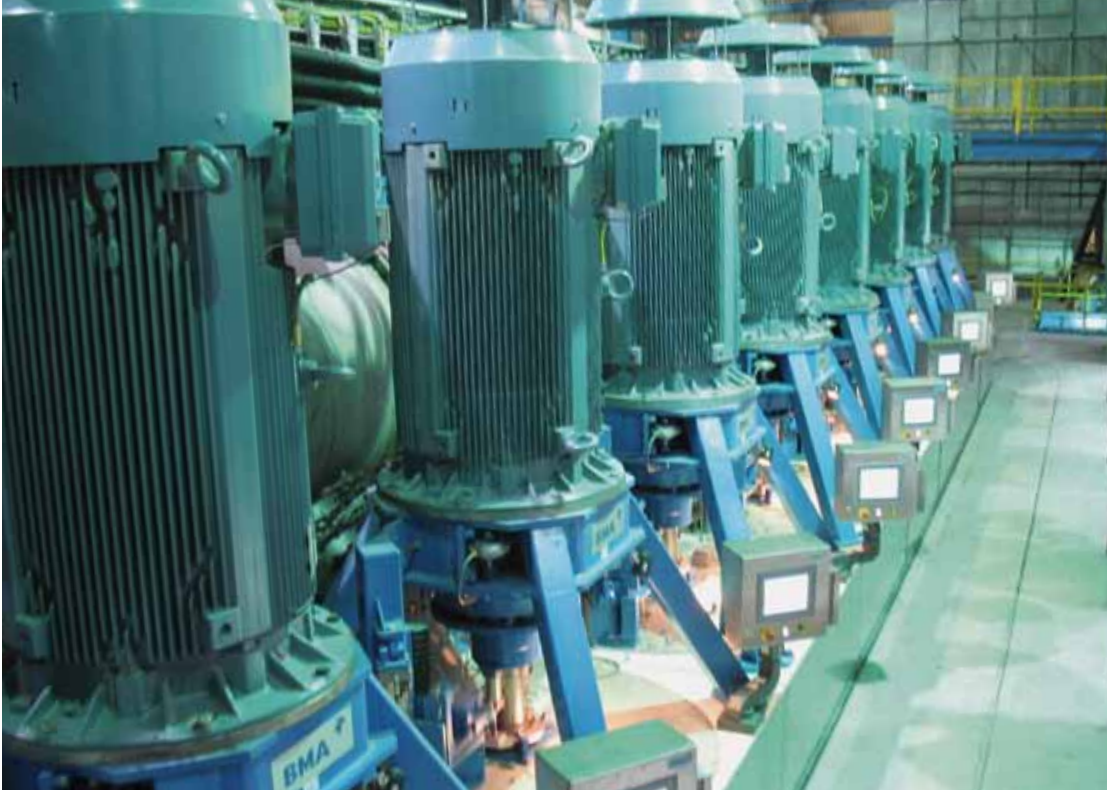
Mise en service de l'atelier de centrifugeuses pour production de sucre raffiné la plus grande au monde (14 B2200 R)
