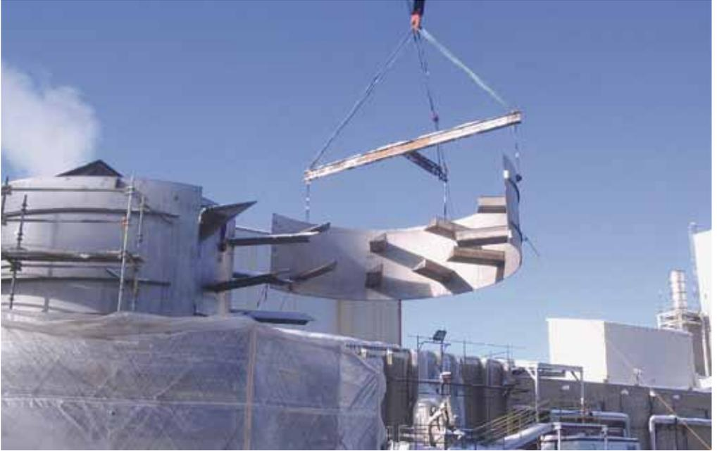
BMA construit actuellement une nouvelle installation de diffusion basée sur la célèbre tour de diffusion 2000 en l'équipant des composants tour de diffusion, malaxeur de cossettes à contre-courant, démousseur, dessableur et classificateur à râteaux. Le client est la sucrerie Moorhead appartenant à American Crystal Sugar au Minnesota et implantée au « Middle West » des Etats-Unis d'Amérique. Sa mise en service est prévue pour la campagne de betteraves 2011 / 2012.
