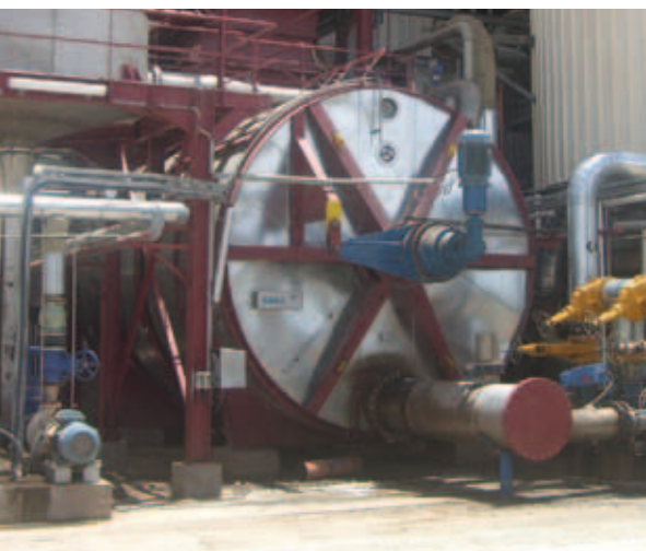
... y macerador de cosetas en contracorriente
