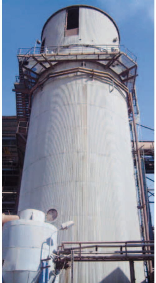
Ejemplo de una instalación de difusión de BMA
