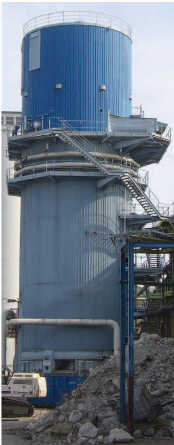
КДА перед демонтажом
