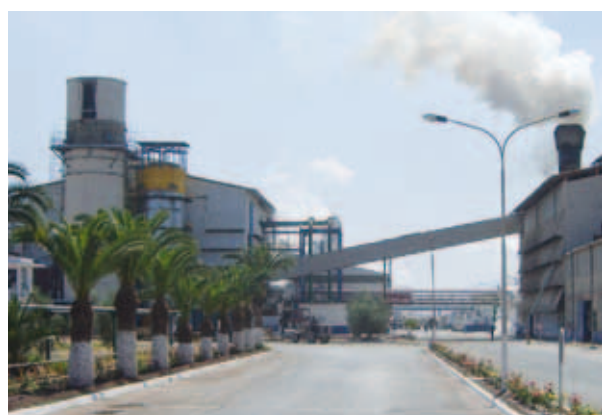
Blick auf das Hauptprozessgebäude
