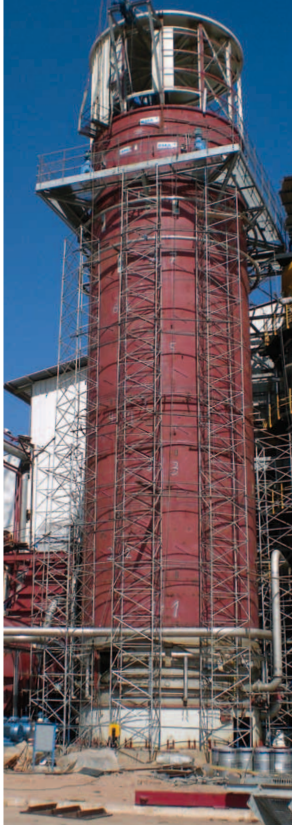
Extraktionsturm während der Montage
