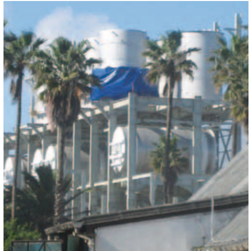
Das neue Produktionsgebäude während der Montagephase
