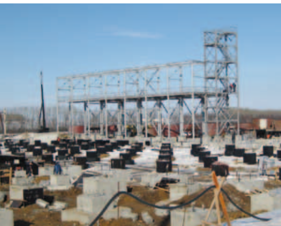
Préparation du chantier
