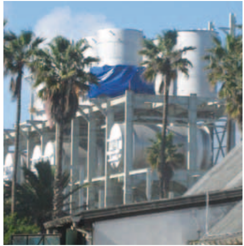
Le nouveau bâtiment de production pendant la phase de montage
