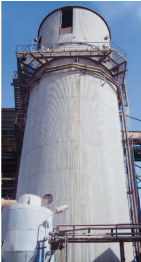
Exemple d'une installation de diffusion BMA
