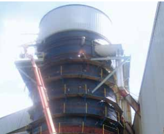
Aumento de la altura de la torre de difusión
