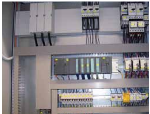
Unidad de control S7 con Simocode para un aparato OVC
