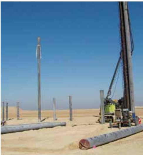
Primeros trabajos a pie de obra
