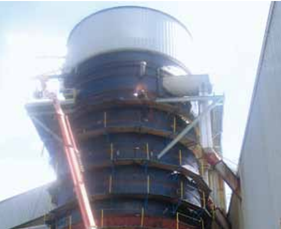
Нарращивание длины колонного диффузионного аппарата
