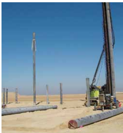
Первые работы на строительной площадке
