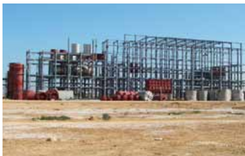
Идёт монтаж металлоконструкций и оборудования в главном корпусе (состояние на 6.1.2009 г.)
