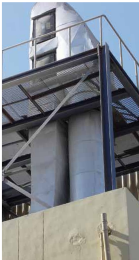
Верхняя рабочая площадка
