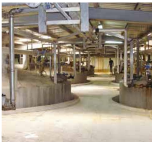
Общий вид установки
