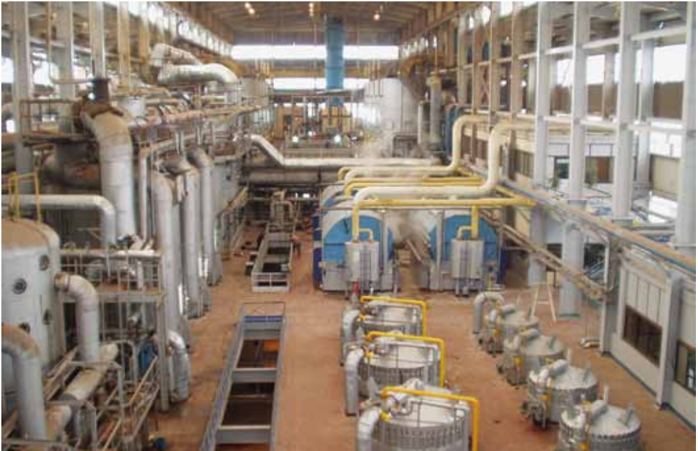
Главный производственный корпус сахарозавода BELKAS
