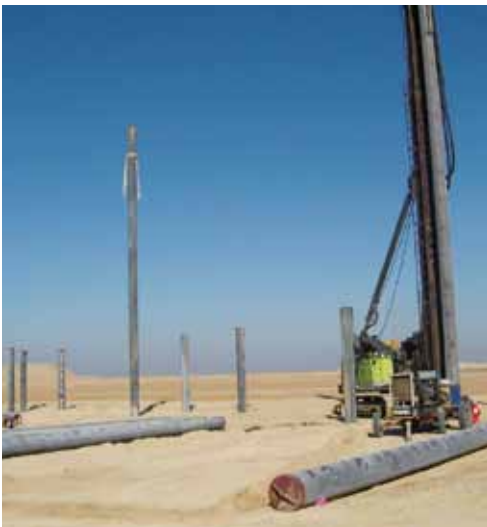
Erste Arbeiten auf der Baustelle
