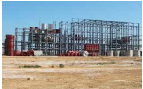
Stahlbau und Ausrüstungen für das Hauptprozessgebäude werden montiert (Stand 6.1.2009)
