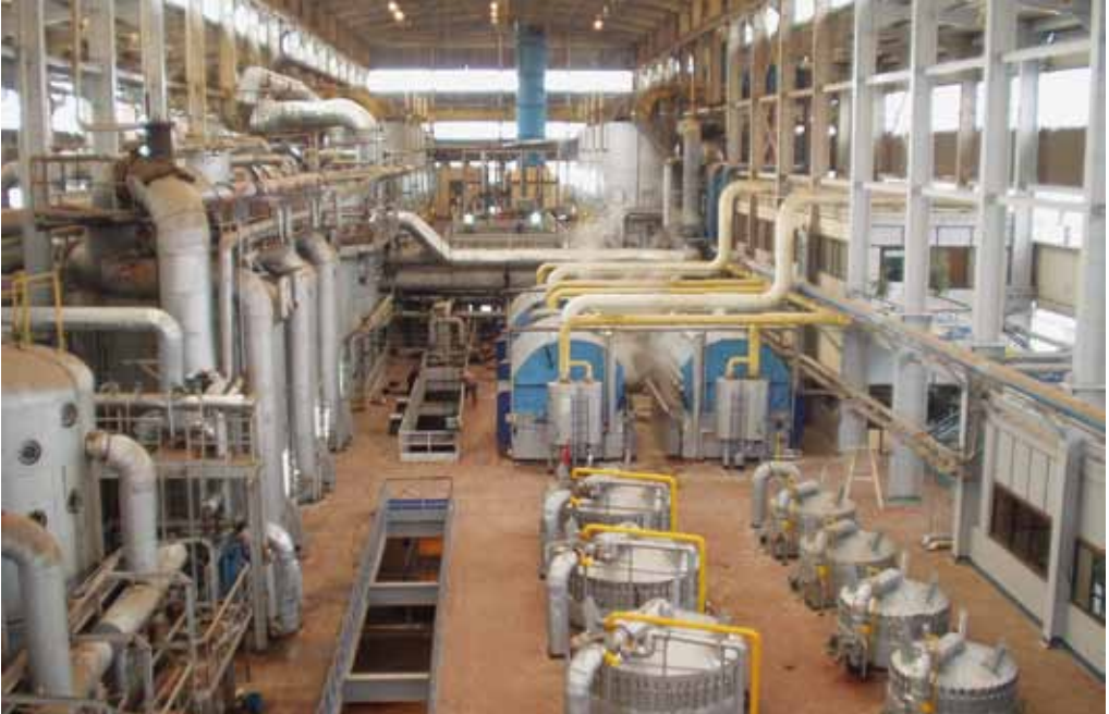
Hauptprozessgebäude der Zuckerfabrik BELKAS
