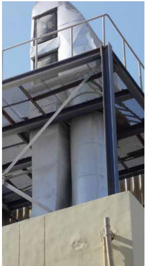
Plancher de service supérieur de l'atelier de trempage
