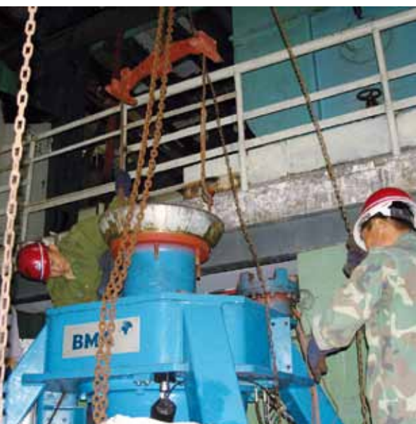
Monteurs de BMA China et COFCO Tunhe lors de l'entretien ordinaire d'une centrifugeuse B
