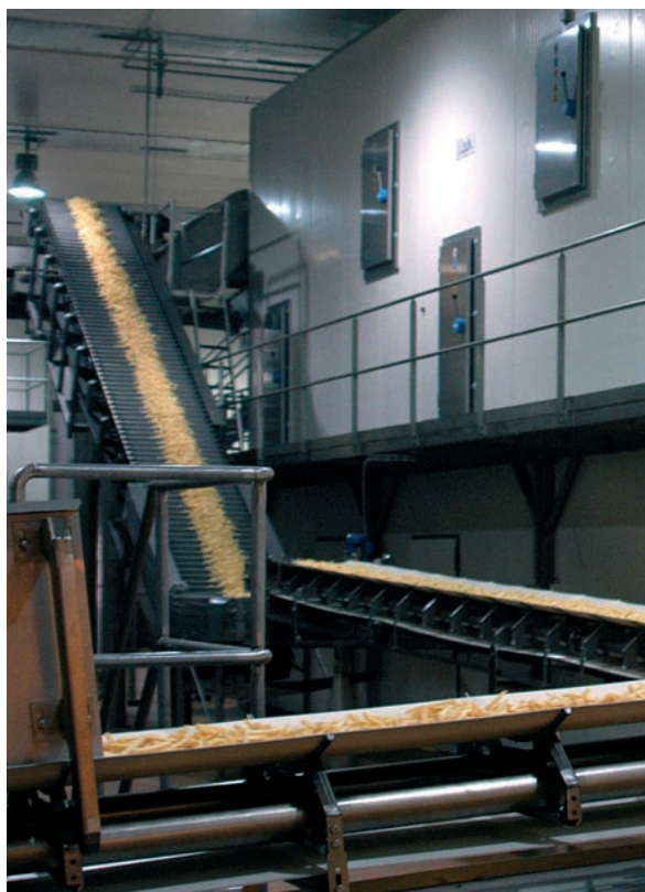
Tunnel de congélation
