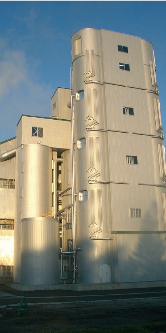
VKT avec habillage de la tour d'escaliers
