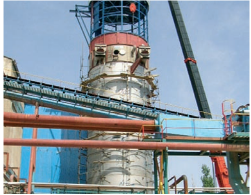
Pendant le montage à Ghazvin
